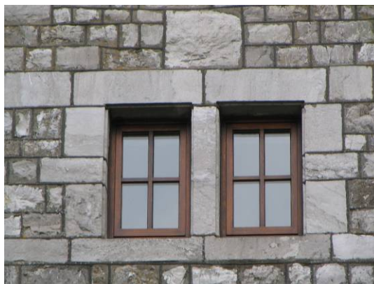
Détail d'une fenêtre géminée
