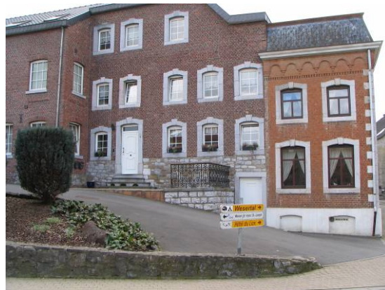
Vue depuis la rue de l'Eglise
