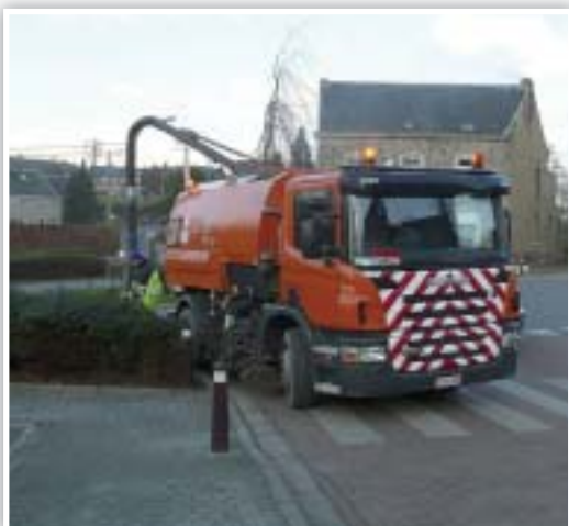
Nettoyage des avaloirs
