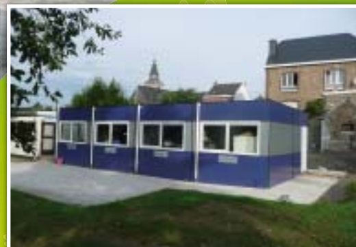
Travaux : modules pour l'école de Membach
