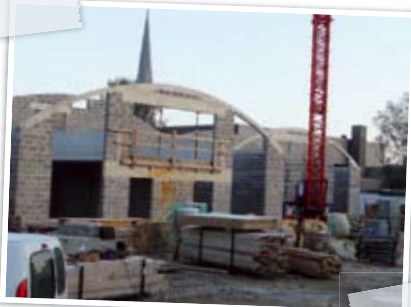
La pose des charpentes ne devrait plus tarder.
