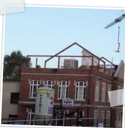
L'avancée des travaux.
