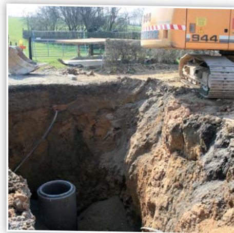
Début avril, la pose d'égouts Chemin de Hoevel a nécessité la pose de canalisation à grande profondeur.
