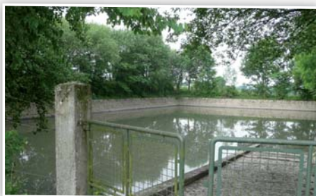
Maintenant, le bassin d'orage peut enfin jouer le rôle pour lequel il a été construit.
