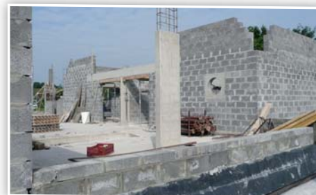
Le chantier de l'école progresse rapidement. Ici, on peut voir se dessiner le premier bâtiment.
