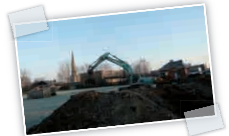
Le terrassement de la nouvelle école a débuté fin janvier dernier.
