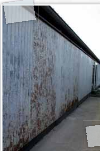
Les modules scolaires de Membach avant l'intervention des jeunes jobistes
