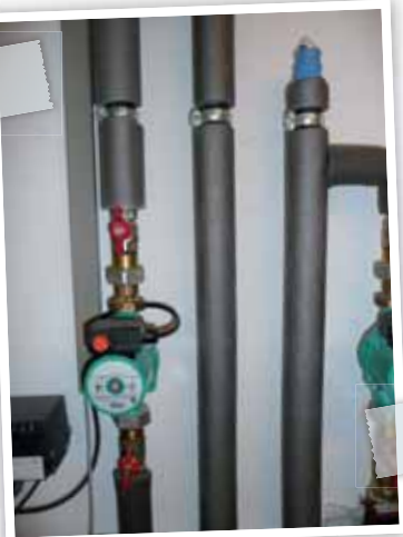
Isoler les tuyaux de chauffage est un jeu d'enfant.
