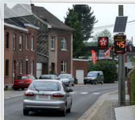
Sur les automobilistes responsables, les radars préventifs ont un effet immédiat de prise de conscience de la vitesse réelle à laquelle on circule.
