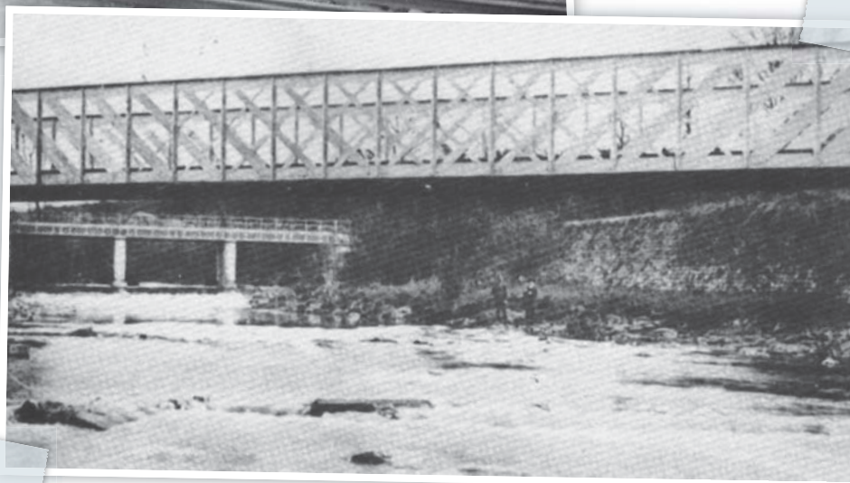
Carte postale libellée : Membach Environs de la Station. Deux ponts sur la Vesdre ont été construits pour permettre la liaison ferroviaire Dolhain-Eupen. Quant à celui de Membach, le Mémoire stipule que les pieds de remblais longeant la Vesdre près de Membach devront être protégés par des revêtements en pierres sèches que l'on distingue sur la carte postale ancienne.
