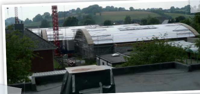
Vus de la maison communale, les 3 toits de la nouvelle école attendent la pose de l'isolation et du revêtement définitif.
