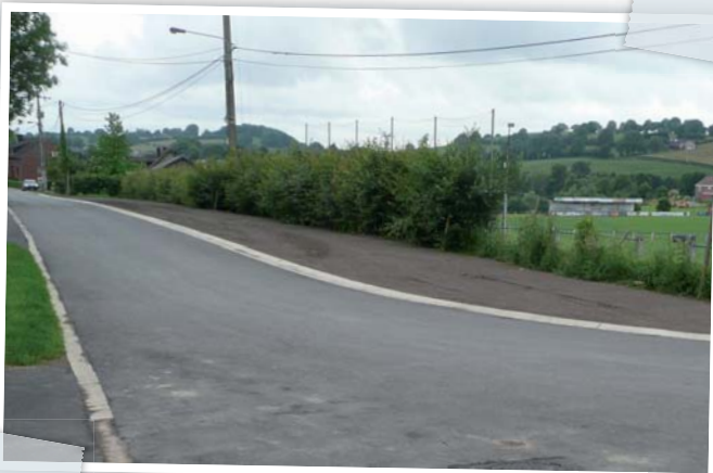
La partie finalisée du chantier vu de l'angle du terrain B du RFC Baelen.
