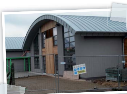
Les travaux de la nouvelle école avancent bien.
