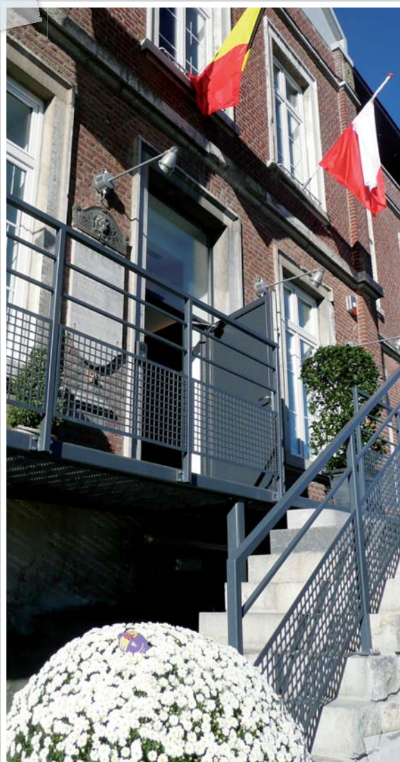
Remise à neuf et fleurie, la maison communale vous ouvre ses portes
