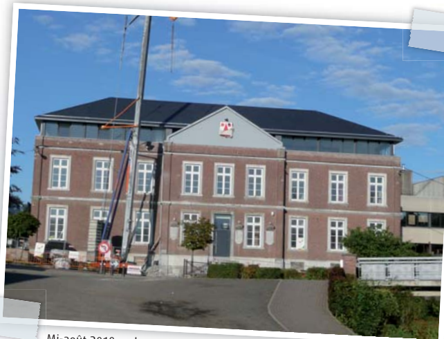
Mi-août 2010: cela sent la fin des travaux, enfin !
