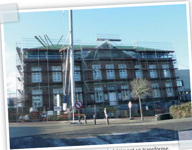
Décembre 2009: l'échafaudage, la grue, le bâtiment se transforme.
