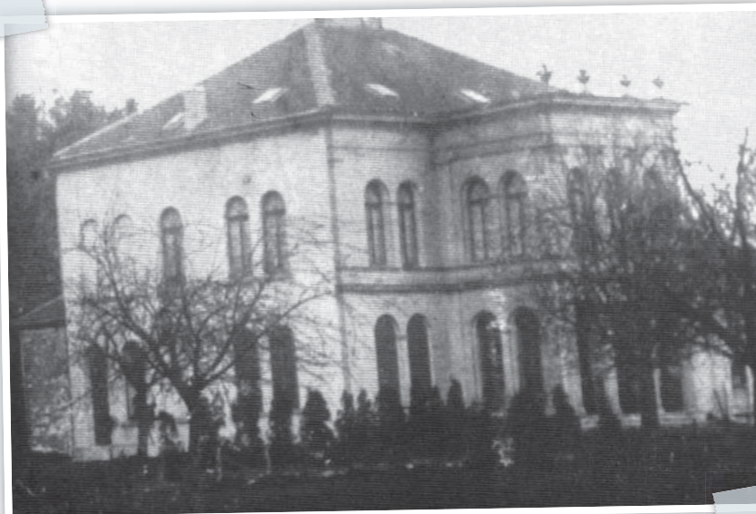
Façade latérale d'une annexe.
