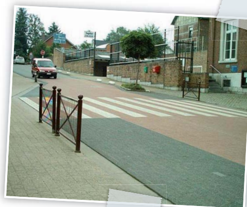
Passage pour piétons localisé en face de l'accès d'entrée et sortie du parking
