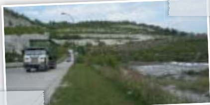
Après exploitation, la zone d'enfouissement est complètement réhabilitée
