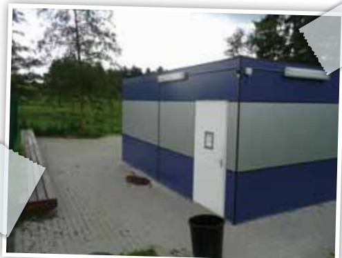
Les abords des modules de l'école de Membach réalisés en klinkers.
