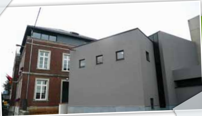
La nouvelle annexe, visible depuis la rue de la Régence
