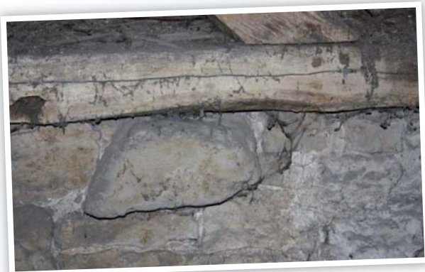
Détail d'un corbeau encastré dans le mur intérieur de la tour mais dont une partie émerge suffisamment pour y poser l'assise du beffroi.
