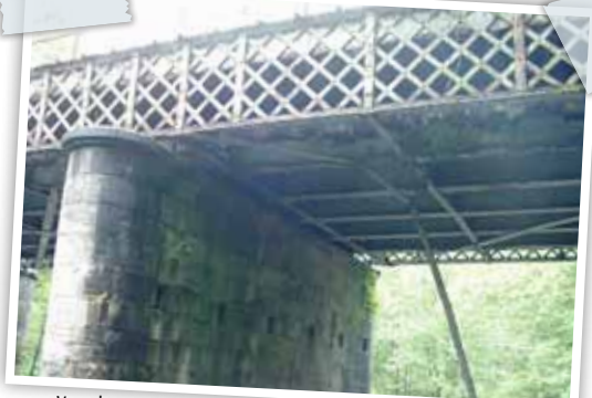
Vue du parapet en 2012
