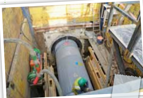
d'impressionnants travaux à Nereth
