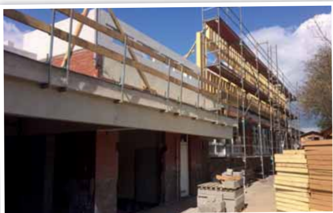
Les travaux avancent bien !
