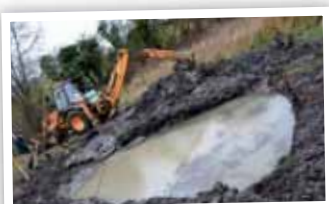
Les terres issues du creusement sont réparties harmonieusement dans la zone.
