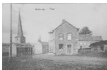
Première maison communale du village dans laquelle se réunissaient les élus et se trouvait l'école primaire ainsi que le logement de l'instituteur.
