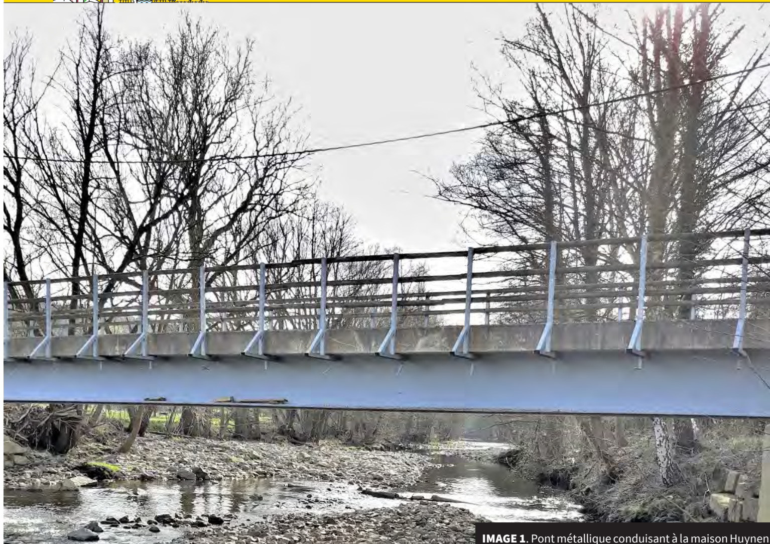
IMAGE 1. Pont métallique conduisant à la maison Huynen
