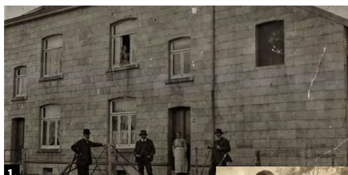
Photo 1 : Maison habitée par la famille Techy, rue de la Station à Membach
